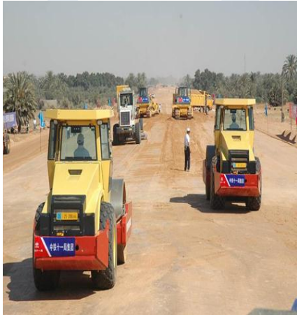
صورة رقم ( 11 ) تمهيد الطريق
