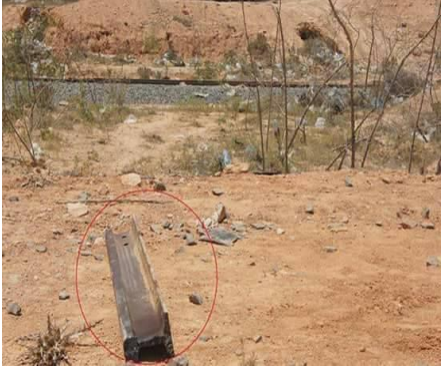
صورة رقم ( 16 ) توضح تفكيك القضبان الحديدية الخاصة بخط وصلة الميناء من قبل اللصوص والسراق.
